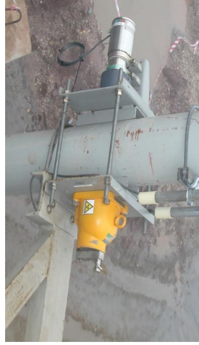
شكل (٢٩) نموذج لمقياس ثابت لتحديد معدل السريان
