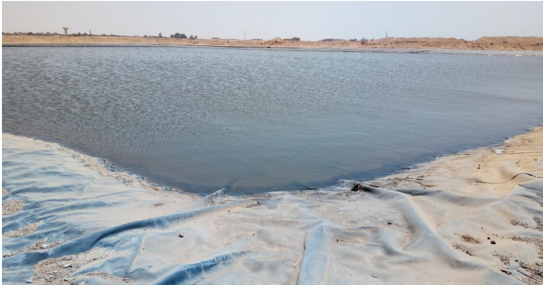
شكل (١٢) نموذج يوضح بحيرات التبخير المبطنة للتخلص من المياه المنتجة
