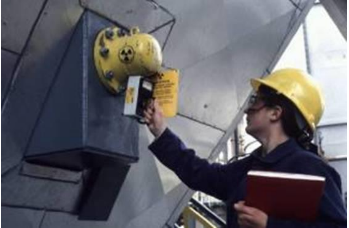
شكل (٢٨) صورة توضح مقياس إشعاعي ثابت لتحديد مستوى السائل داخل الوعاء
